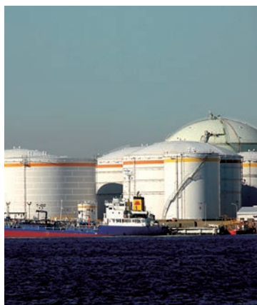
LNG プラント
