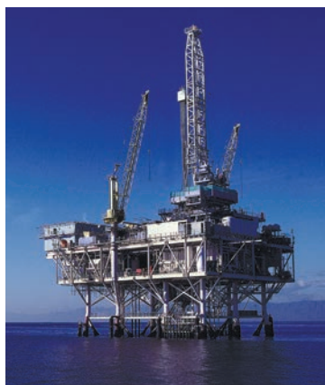
石油海上プラント
